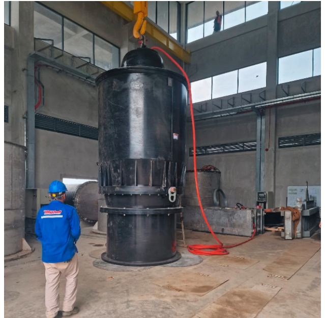
Die 10.000 l/s SAF-Pumpe von Bedford bei der Installation vor Ort
